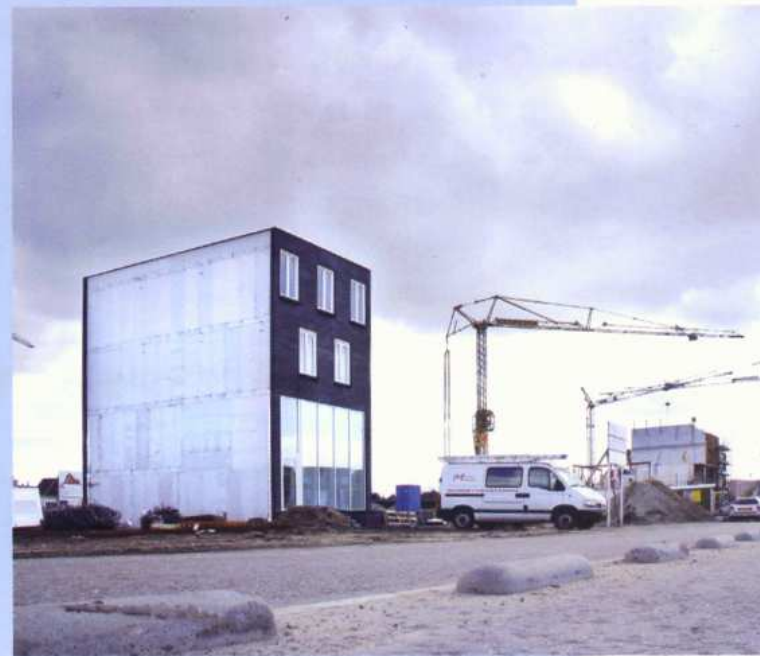
Het eerste huis aan de Lonnekerspooorlaan
